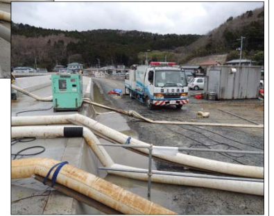
排水ポンプ車稼働状況
