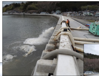
排水ポンプ車稼働状況
