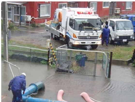
排水ポンプ車による排水作業状況(眼鏡筒排水機場)
