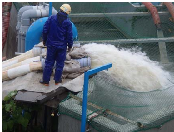
排水ポンプ車による排水作業状況(眼鏡筒排水機場)
