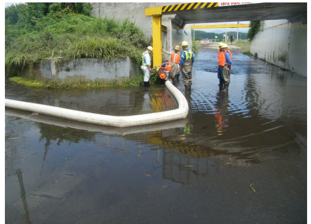
【 排水ポンプ車による内水排除状況 】 大館市松木地内（大館市道）
