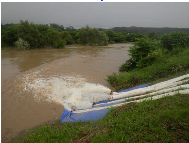
紫波町 高水寺地区ポンプ排水状況
