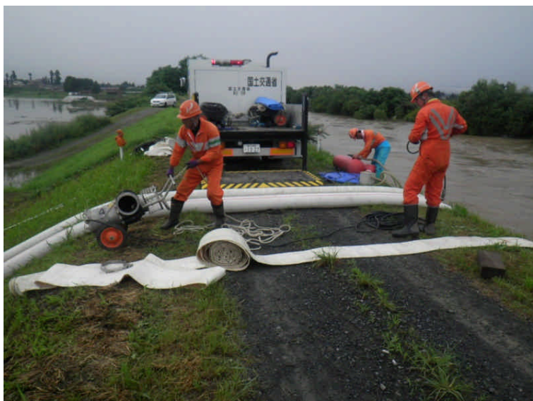
紫波町 高水寺地区ポンプ設置状況
