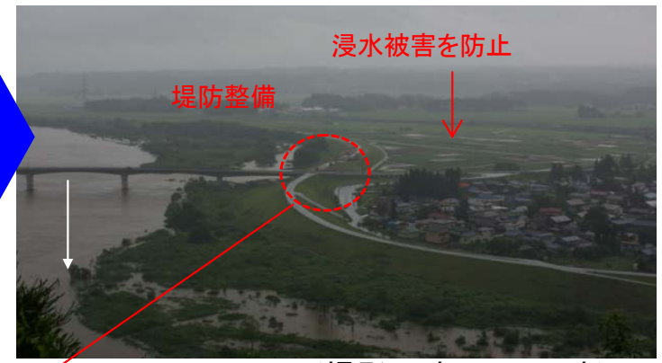
H25.7出水状況
