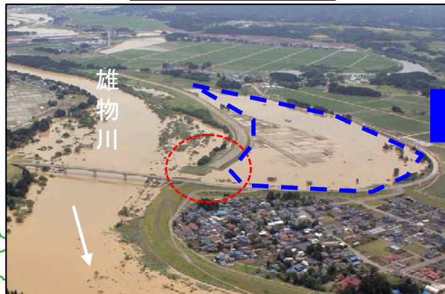
H23.6出水状況
