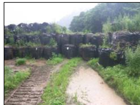
大型土のう126袋(延長約50m)を設置 (7月12日17時50分 設置完了)
