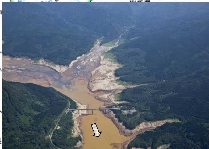
玉川ダム貯水池状況(H24.8.28)
