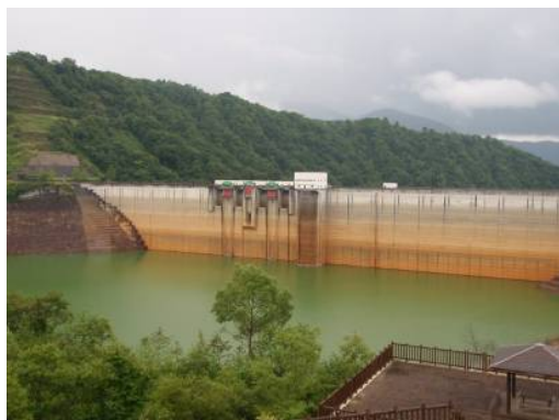
▲雄物川水系玉川ダム(秋田県仙北市) 貯水率7%の貯水状況 【平成24年9月5日撮影】
