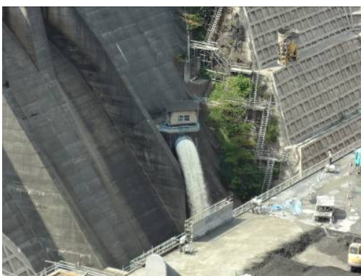
▲岩木川水系目屋ダム(青森県) 非常用バルブからの補給状況 【平成24年8月11日撮影】
