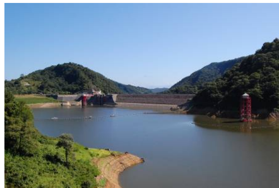
▲最上川水系白川ダム(山形県飯豊町) 貯水率20%の貯水状況 【平成24年9月7日撮影】
