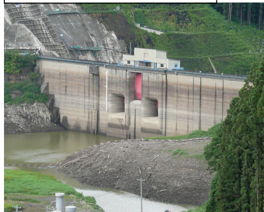
8月13日目屋ダム堤体付近
