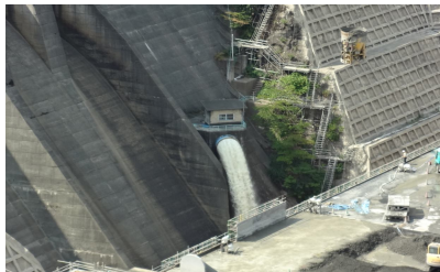
目屋ダムから緊急放流(8月11日)
