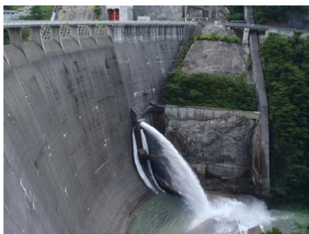
非常用バルブ放流の状況（8月21日撮影）
