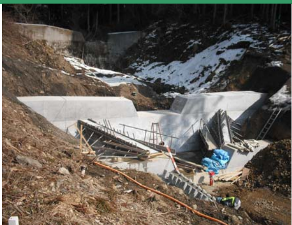
左記、道路改良工事に伴う谷止め工、施工の様子
