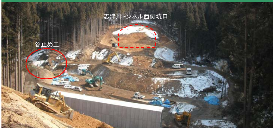
平成24年3月6日、道路改良工事施工状況(写真中央部の切土面が志津川トンネル西側坑口)
