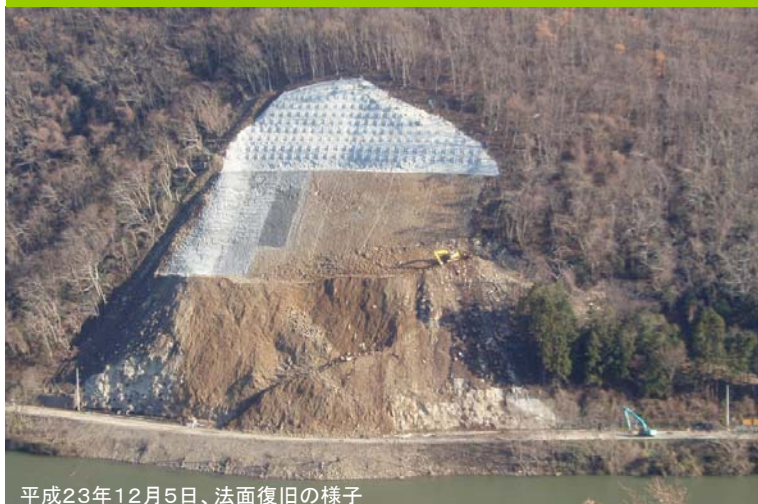
平成23年12月5日、法面復旧の様子
