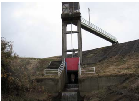
鬼橋排水樋管
