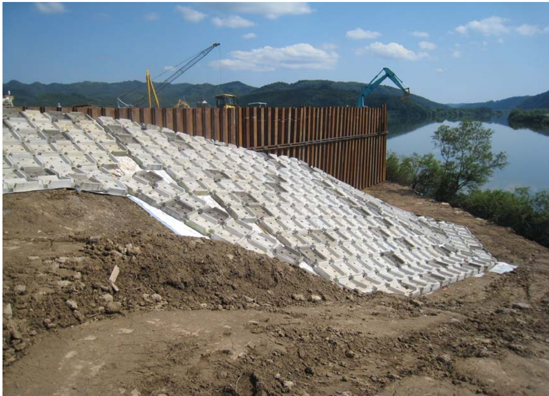
仮堤防設置完了状況
