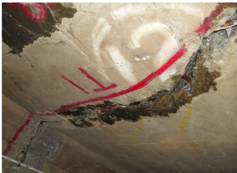
函体の亀裂・沈下状況
