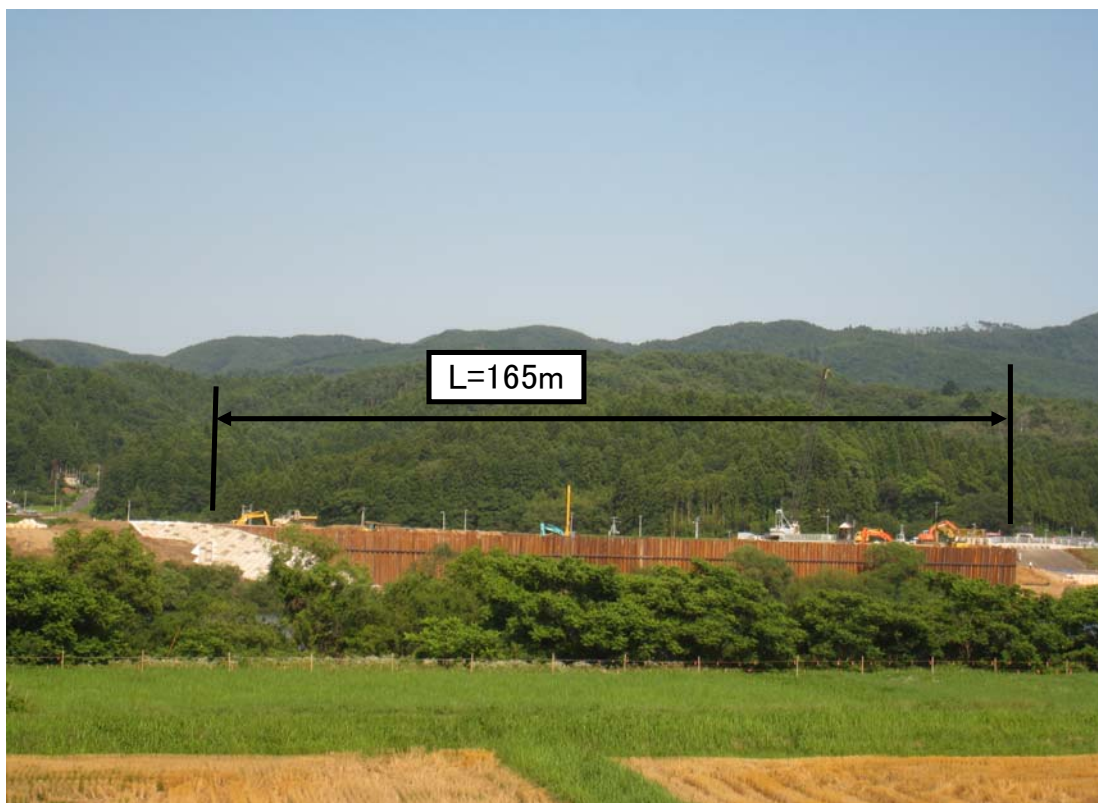
仮堤防設置完了状況
