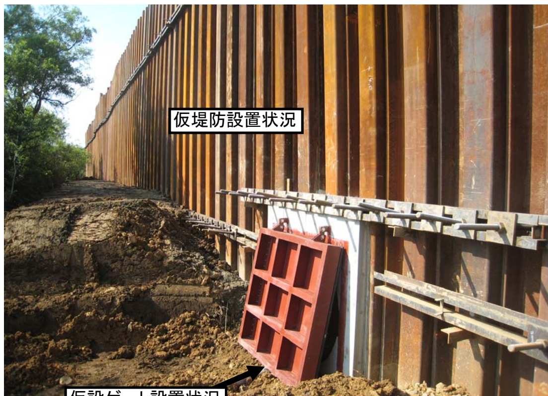
仮堤防設置完了状況
