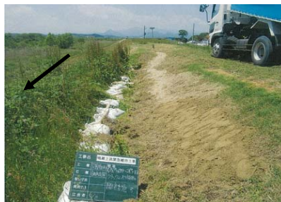
土砂充填完了
