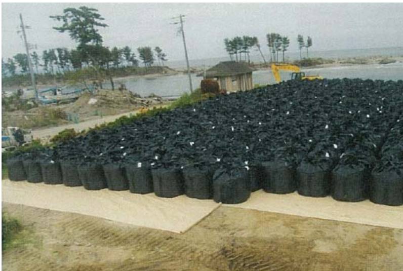
東松島市浜市での 大型土のう製作状況
