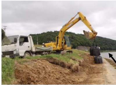
大型土のう設置
