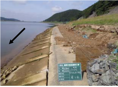
布団カゴ流出 石巻市相野谷(北上川左岸11.0k付近) の応急復旧の状況
