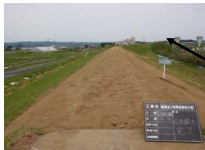
応急盛土完了
