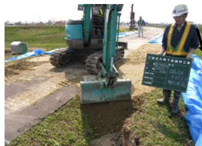
堤防の亀裂・沈下 大崎市古川鶴ヶ埵(江合川右岸26.0k付近) の応急対応の状況
