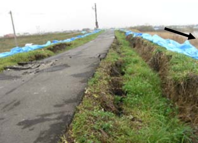
堤防の亀裂・沈下 大崎市古川鶴ヶ埵(江合川右岸26.0k付近) の応急対応の状況
