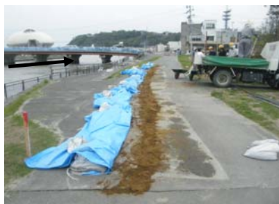
土砂充填完了
