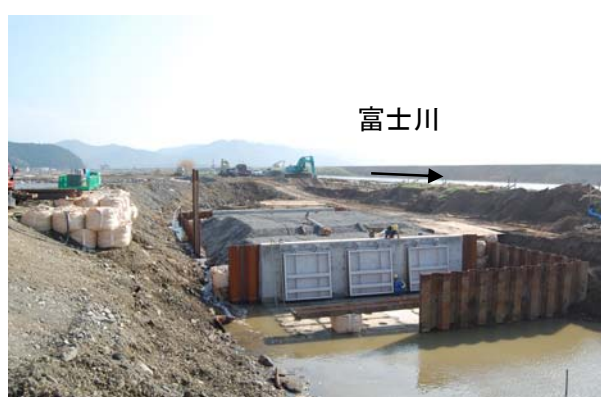
仮樋門設置作業状況
