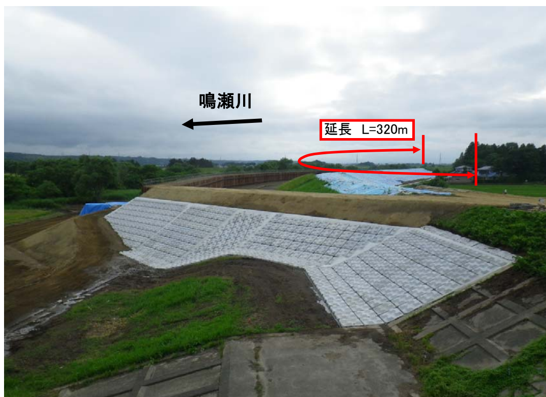
緊急復旧工事完了
