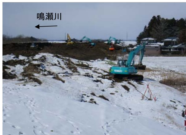
堤防沈下の復旧盛土状況 3月18日 撮影
