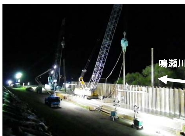
鋼矢板打ち込み状況
