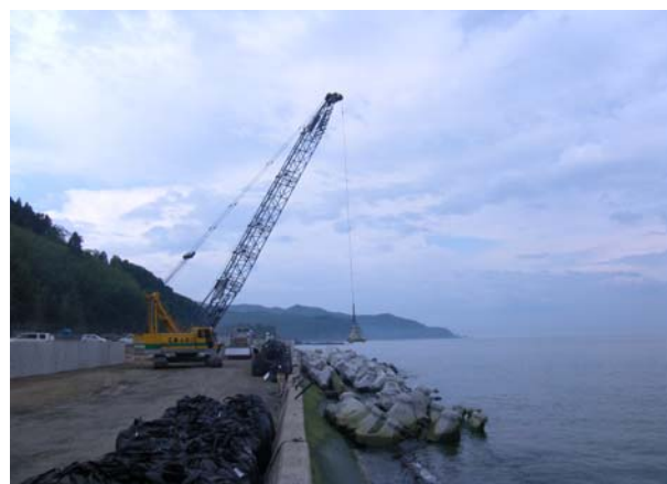
消波ブロック設置状況 6月21日 撮影
