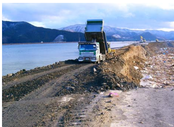
堤防復旧盛土作業状況 3月16日 撮影
