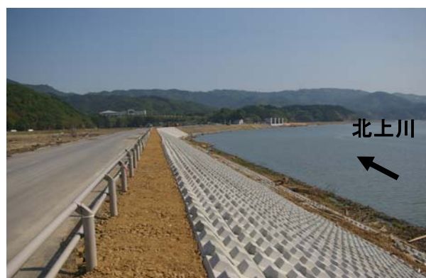
緊急復旧工事完了 6月24日 撮影
