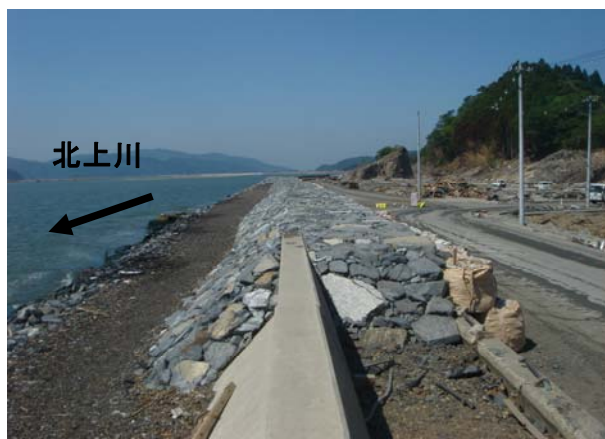
緊急復旧工事完了 6月24日 撮影
