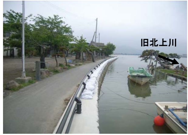
②緊急高潮対策実施状況 ※6月 2日撮影 (石巻市住吉町)
