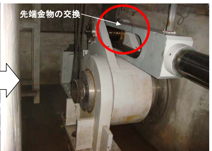
緊急復旧工事により復旧完了
