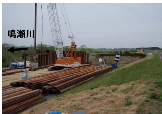
復旧作業状況 仮堤防設置状況(鋼矢板二重締切) 5月11日 撮影
