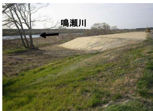
復旧作業状況 押さえ盛土完了 4月18日 撮影
