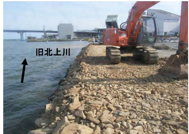
④緊急高潮対策実施状況 ※6月15日撮影 (石巻市南浜町)
