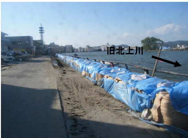
③緊急高潮対策実施状況 ※6月 6日撮影 (石巻市門脇町)
