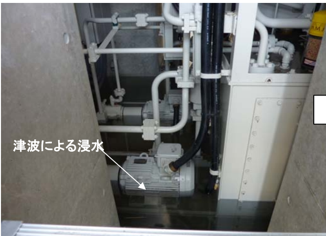
津波により浸水したゲート動作用の油圧ユニット
