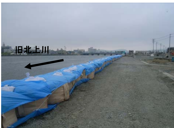
⑤緊急高潮対策実施状況 ※6月10日撮影 (石巻市湊町)
