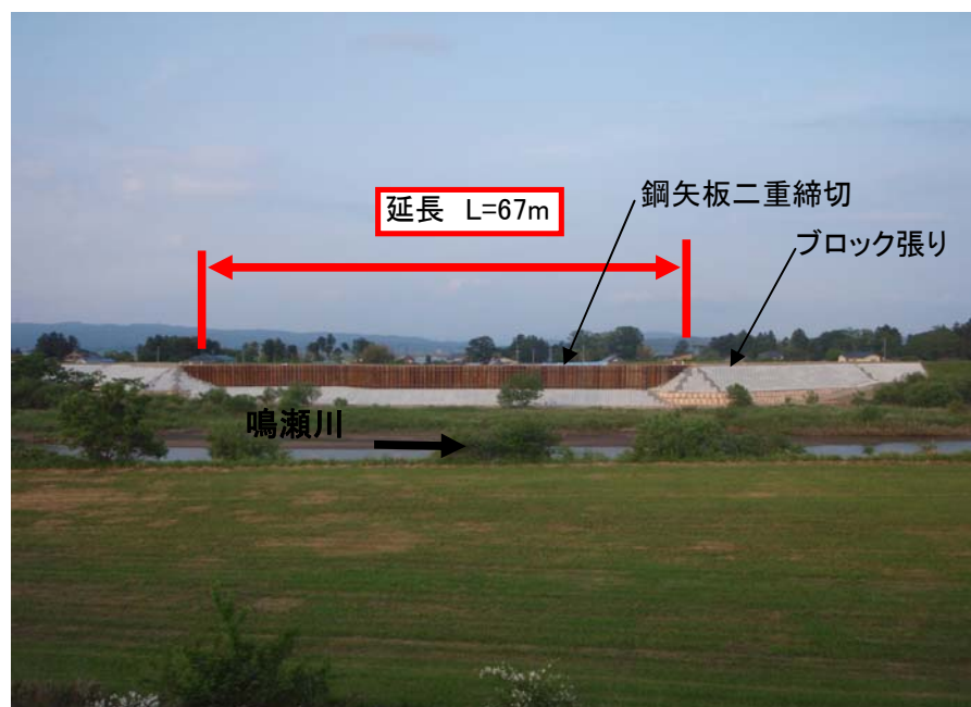
復旧作業状況 仮堤防設置状況(鋼矢板二重締切) 5月11日 撮影
