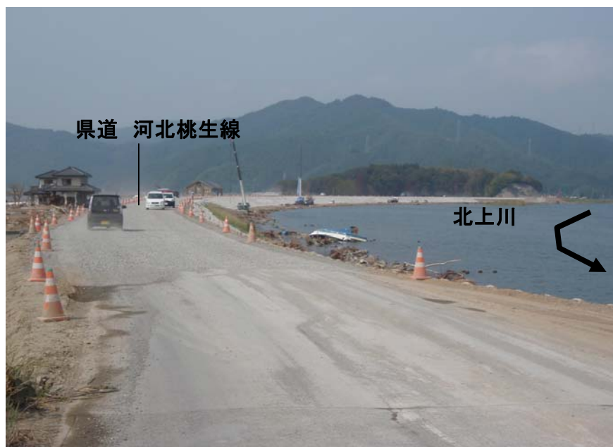
緊急復旧 道路の堤防天端切り替え完了 6月10日 撮影
