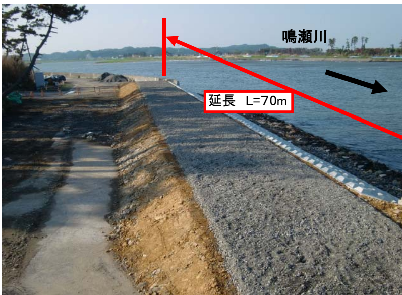
緊急復旧工事完了
