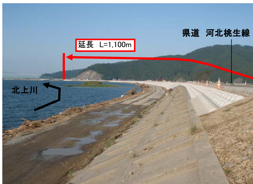
緊急復旧工事完了 6月11日 撮影
