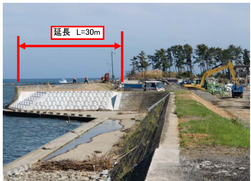
緊急復旧工事完了
