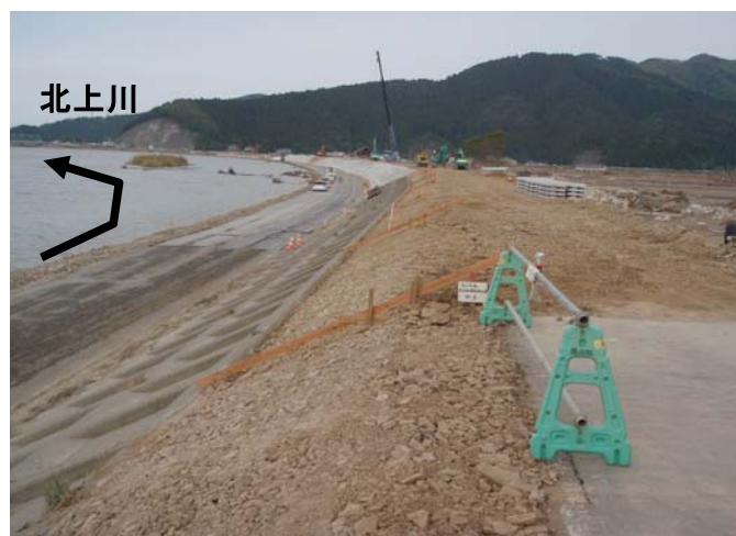
復旧作業状況 復旧盛土・緊急道路 5月17日 撮影
