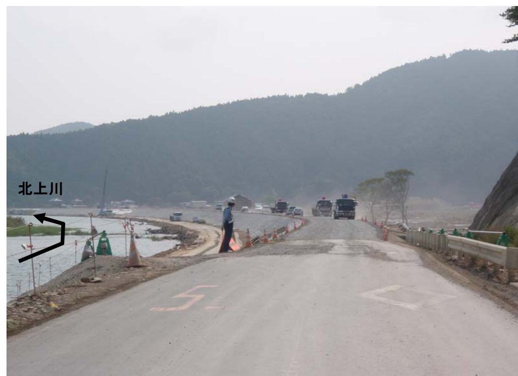
復旧作業状況 道路の堤防天端 への切り替え
