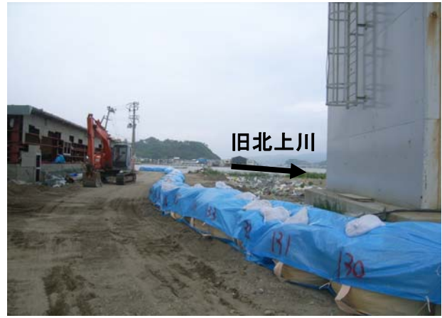
④緊急高潮対策実施状況 ※6月 1日撮影 (右岸日和大橋)
