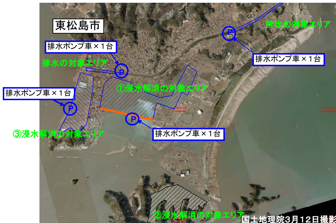
東松島市東名地区、浸水解消の対象エリア 現在、排水ポンプ車合計 4台 で排水中。
