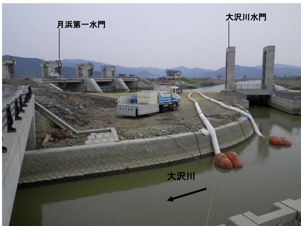
月浜第一水門付近での排水実施状況
