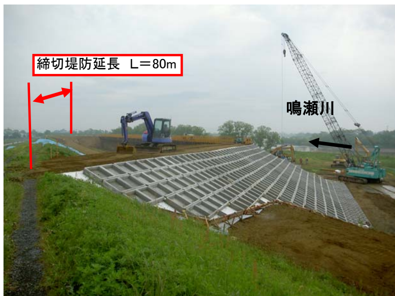
矢板打込・ブロック張り完了 緊急復旧工事完了 5月21日 撮影
