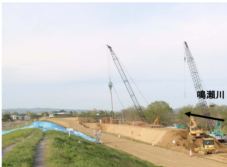
矢板打込実施状況 5月9日 撮影
