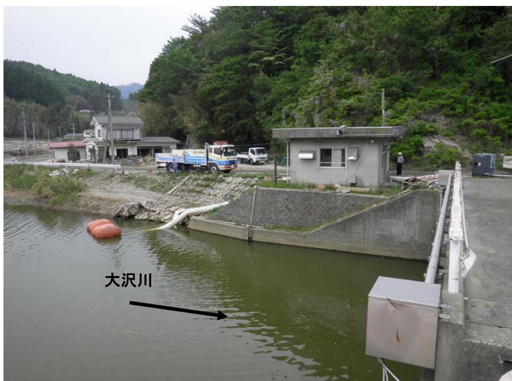
月浜第二水門付近での排水実施状況
