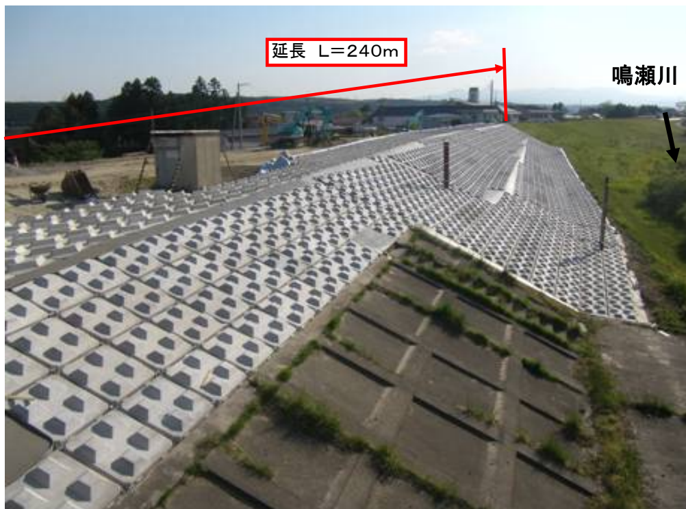
ブロック張り完了
