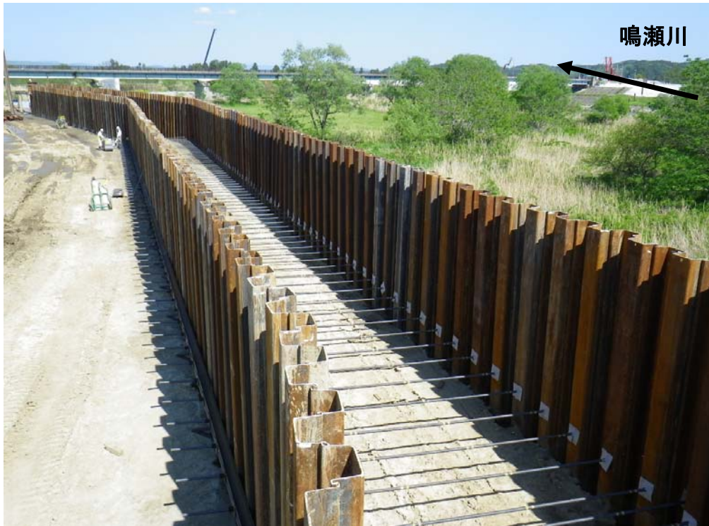
鋼矢板(堤防締め切り用)打込完了
