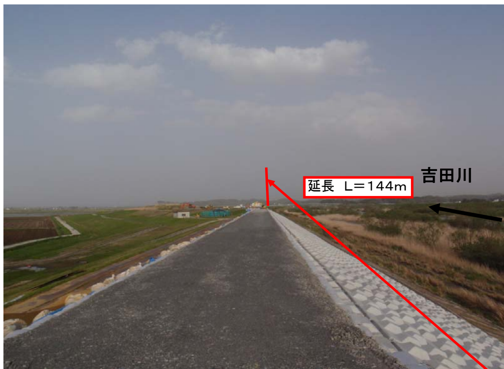
緊急復旧工事完了
