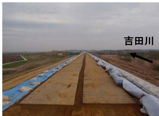
復旧盛土完了
