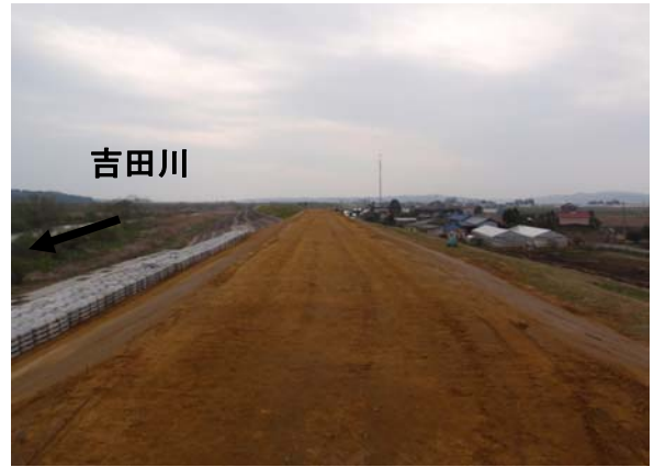
復旧盛土完了
