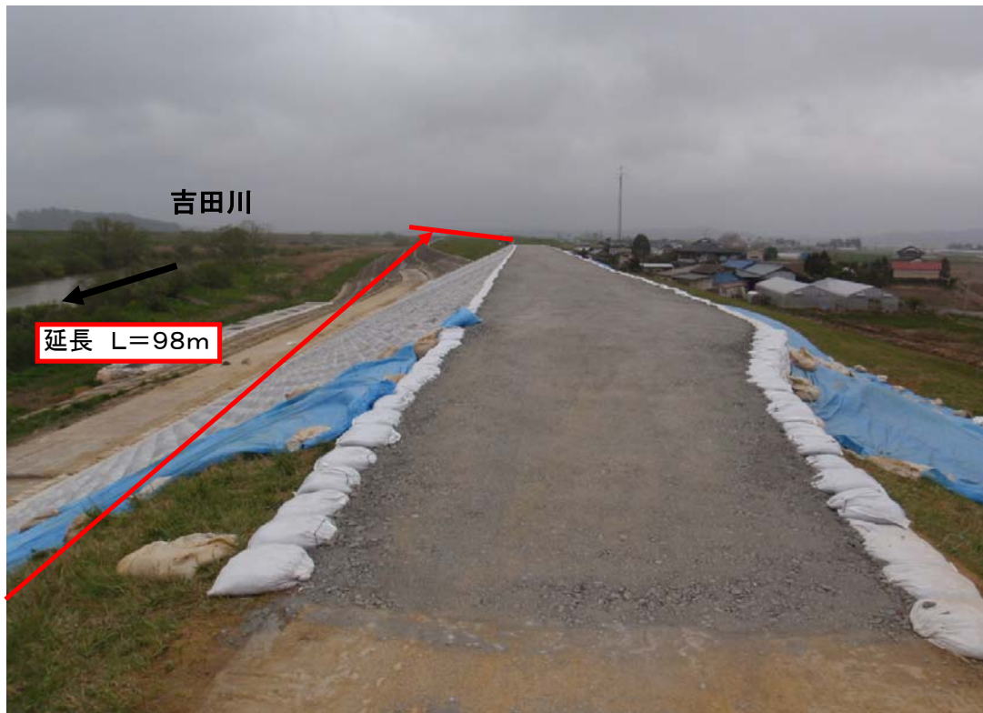
緊急復旧工事完了
