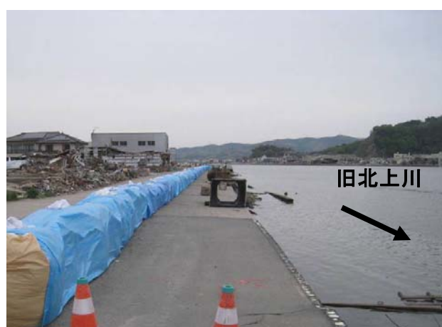
緊急高潮対策、設置状況 ※ 5月11日撮影 (石巻市門脇町)
