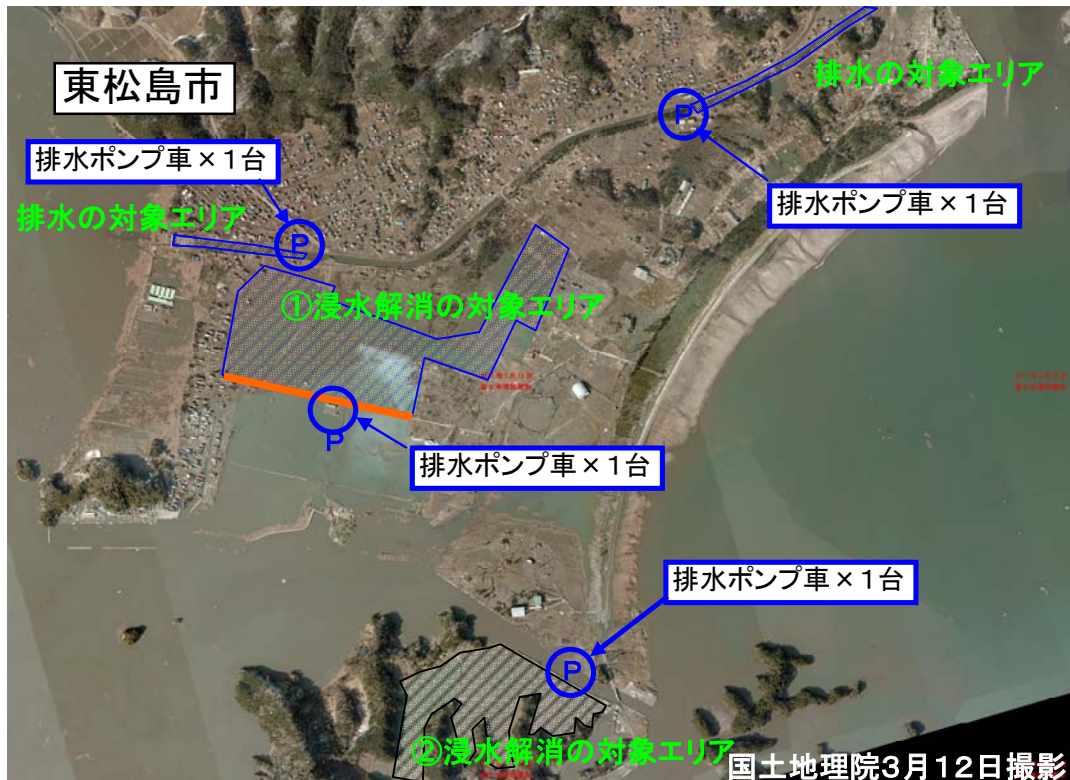
東松島市東名地区、浸水解消の対象エリア 現在、排水ポンプ車合計 4台で排水中。
