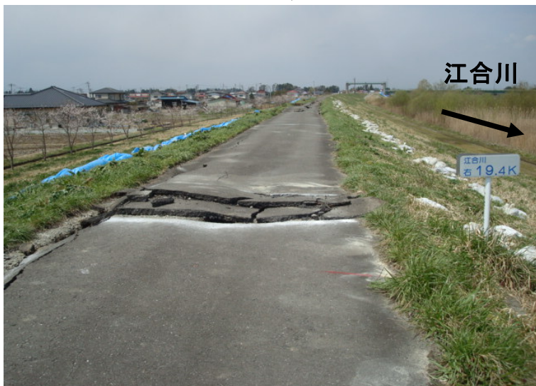
江合川での緊急補修の状況 (美里町北浦地先)
