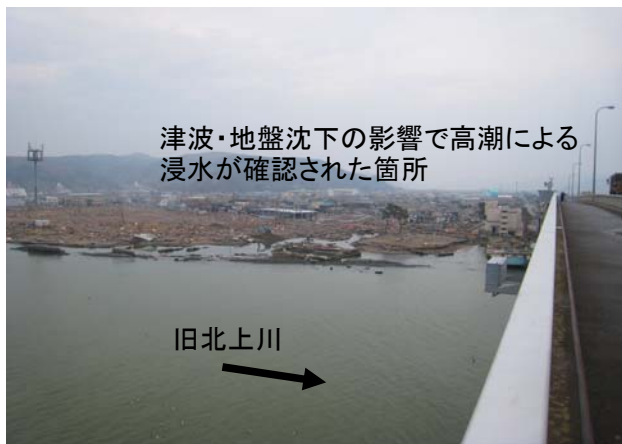
緊急高潮対策、実施前の状況 (石巻市川口町) ※ 5月1日 日和大橋から撮影
