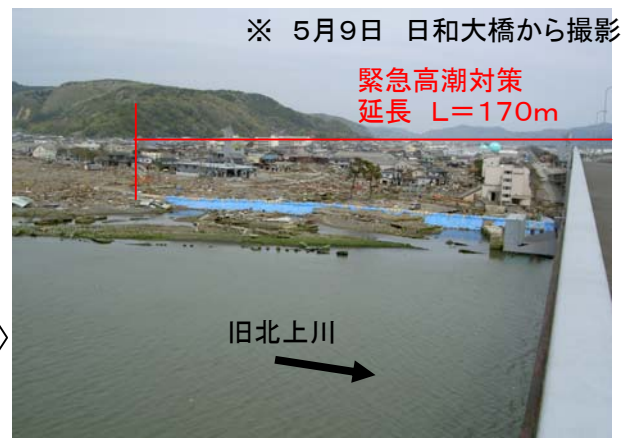
緊急高潮対策、設置状況(石巻市川口町)
