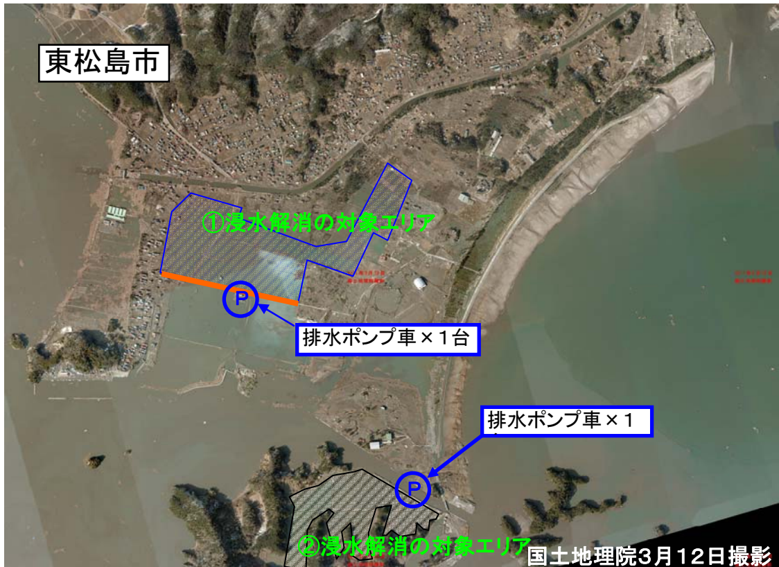
東松島市東名地区、浸水解消の対象エリア 現在、排水ポンプ車合計 2台で排水中。
