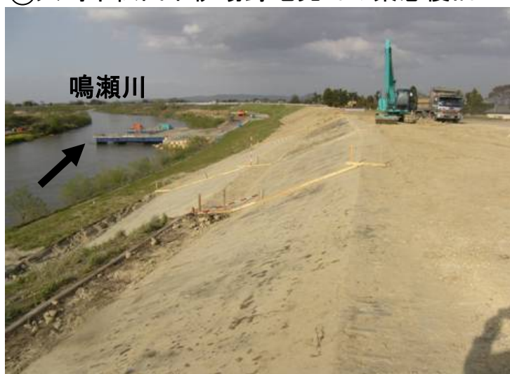
復旧盛土、法面整形 ※ 5月4日撮影
