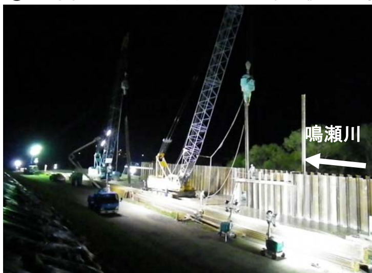
鋼矢板打込 ※ 5月4日撮影
