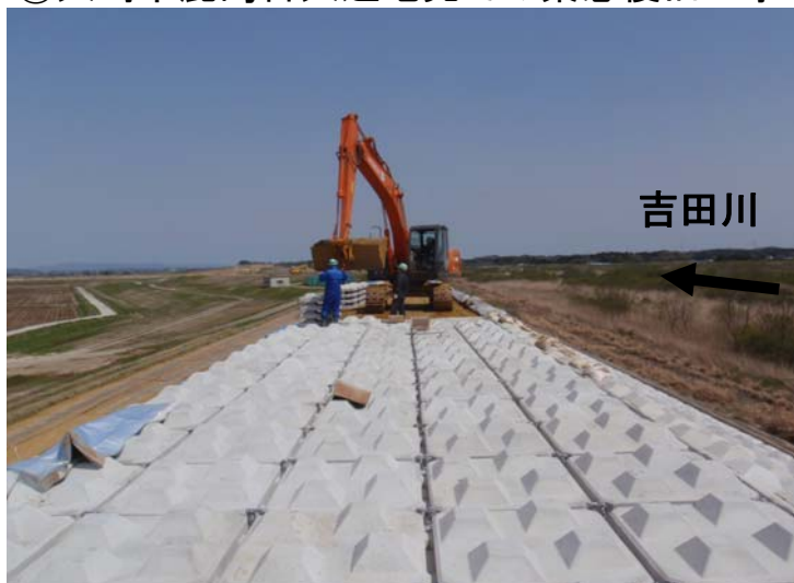
コンクリートブロック張り ※ 5月4日撮影
