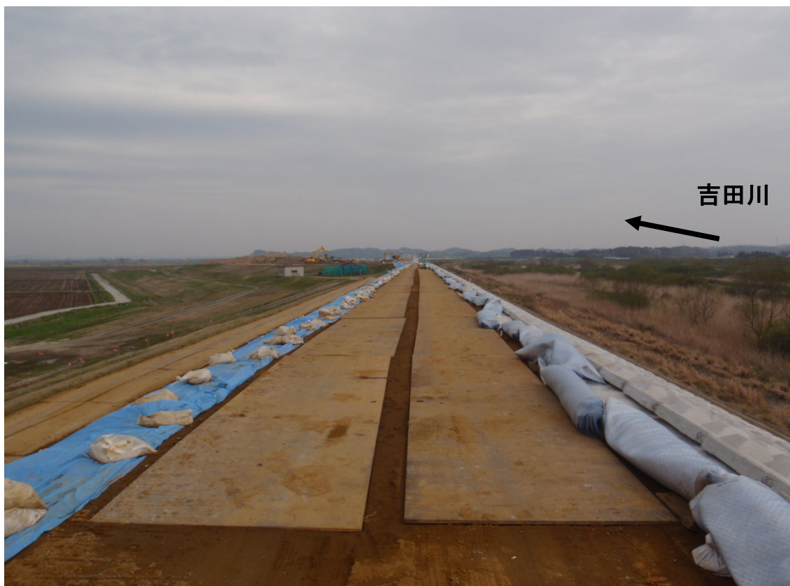
緊急復旧工事の実施状況 復旧盛土完了
