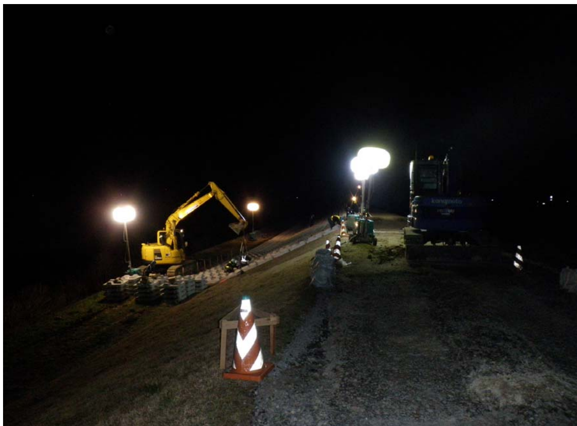
24時間体制で実施したブロック張り作業状況 ※4月30日撮影
