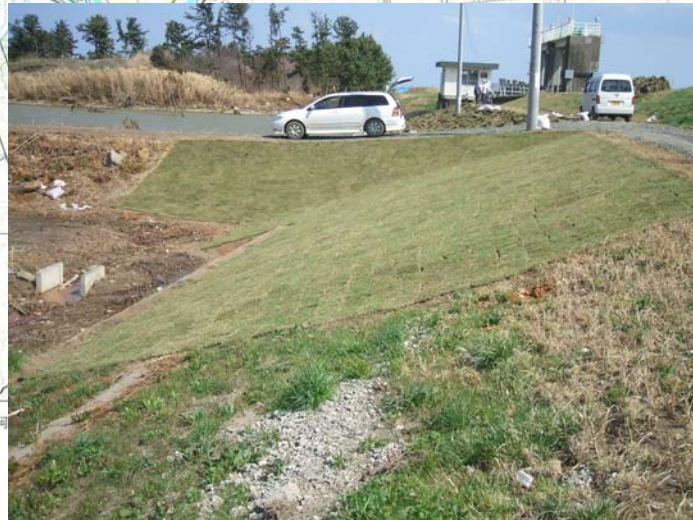
補修完了(4/28 14時撮影)
