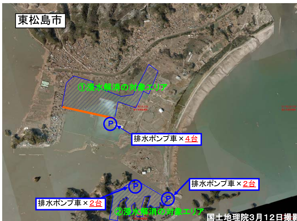
東松島市東名地区、浸水解消エリア 現在、排水ポンプ車合計 8台で排水中。
