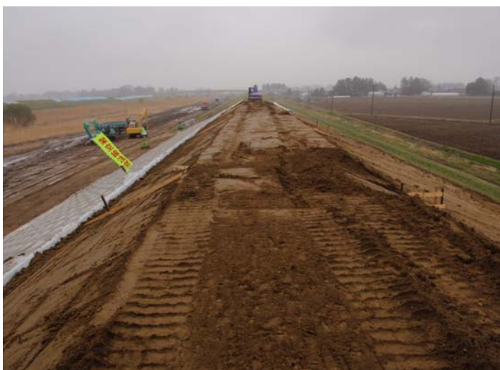
復旧盛土作業中 ※4月22日撮影
