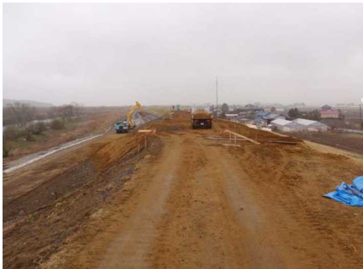
復旧盛土作業中 ※4月22日撮影
