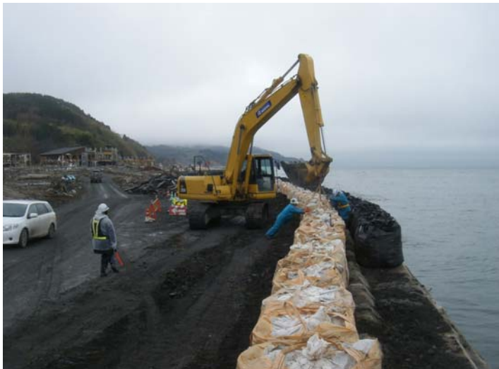
荒締め切り作業中 ※4月22日撮影
