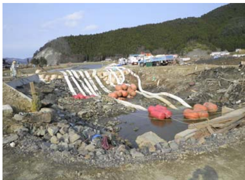
排水ポンプ車での排水による富士沼の水位低下状況 ※ 4月21日 撮影
