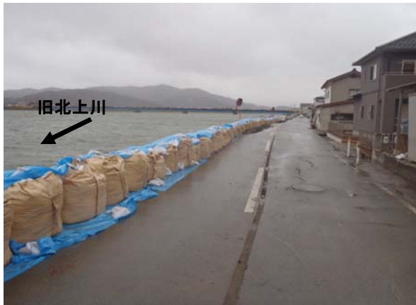
緊急高潮対策、現在の実施箇所 石巻市不動町での大型土のう積みによる 緊急対策 ※ 4月19日撮影
