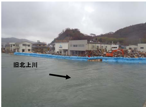
緊急高潮対策、現在の実施箇所 石巻市八幡町での盛土と大型土のう積 みによる緊急対策 ※ 4月19日撮影
