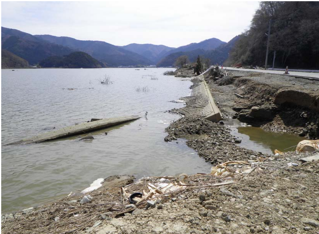
排水ポンプ車で排水による富士沼の水位低下状況
