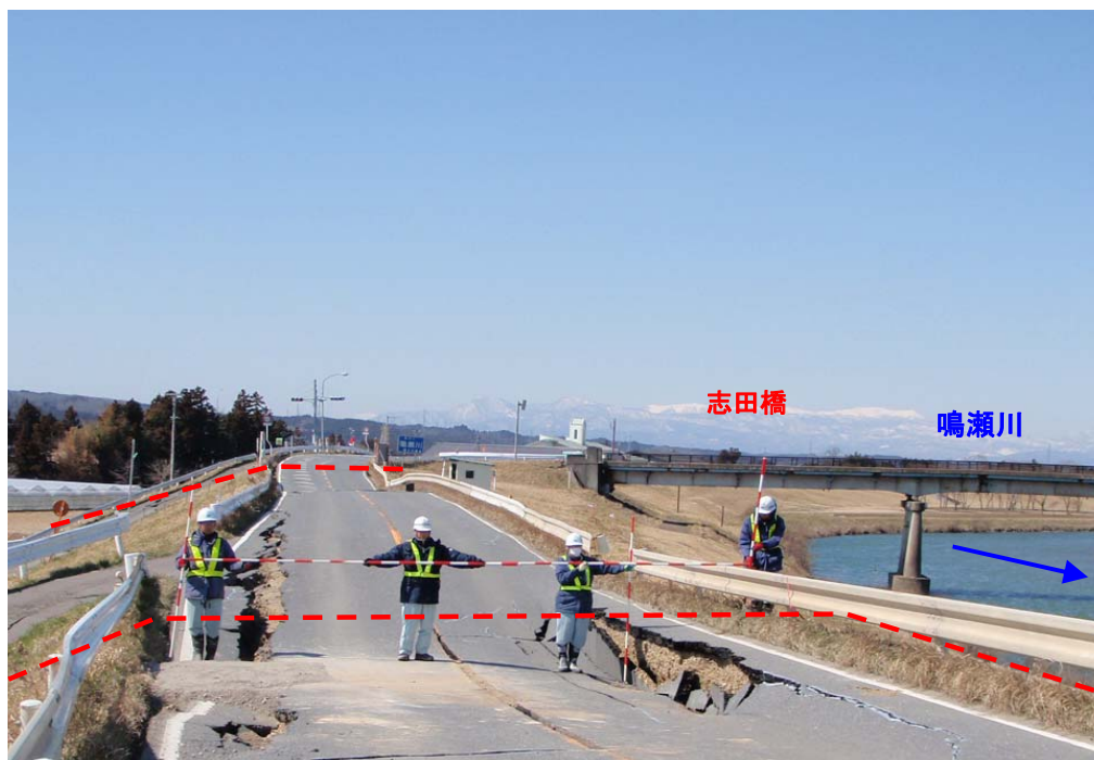
4月17日、緊急復旧工事に着手 堤防沈下、堤防亀裂、堤防斜面の崩れ
