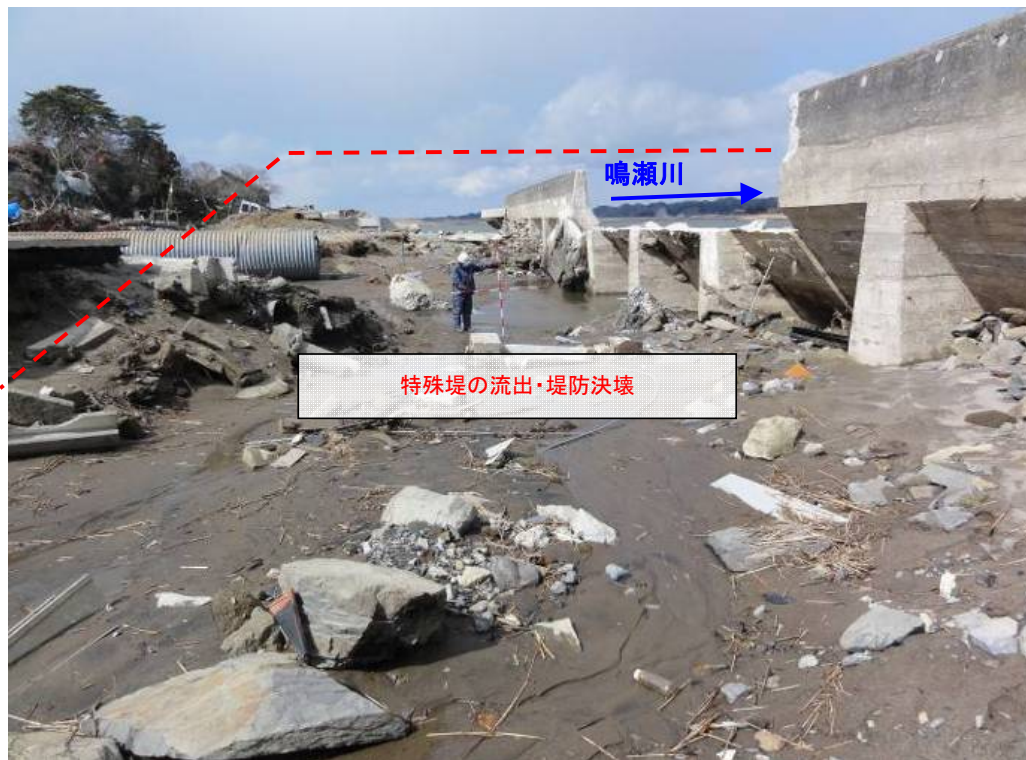
4月17日、緊急復旧工事に着手 特殊堤流失
