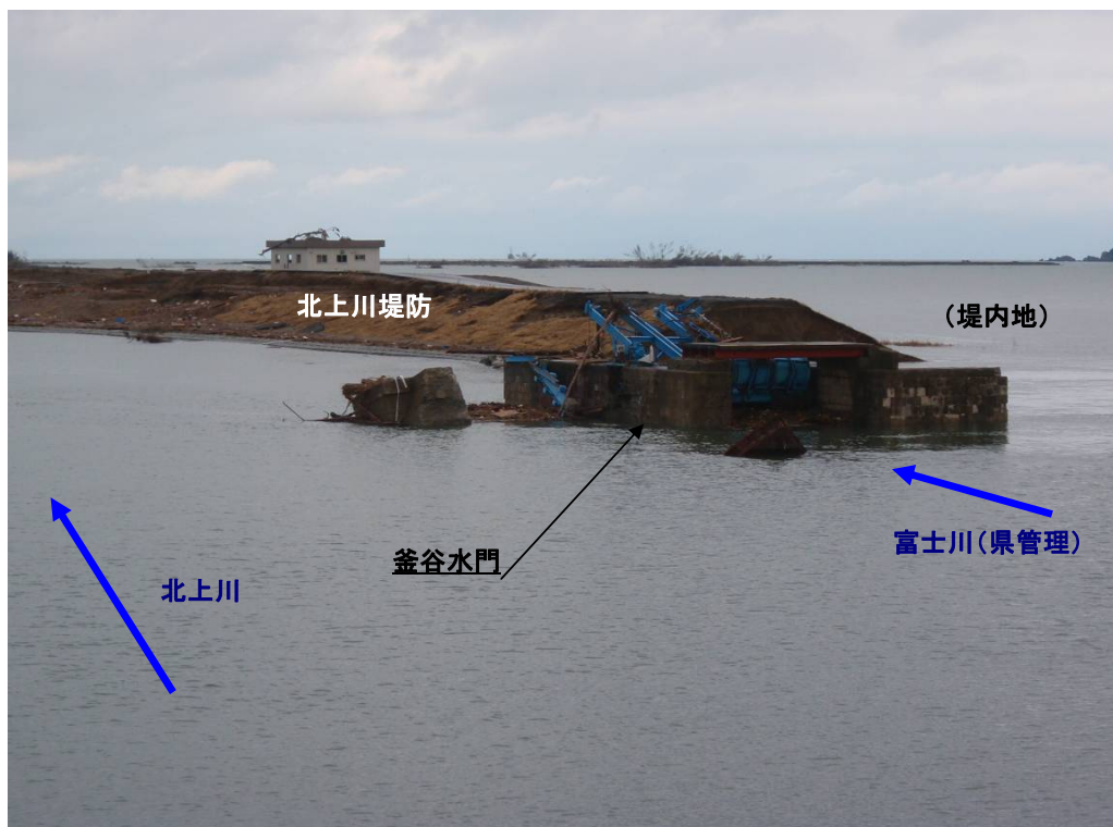
4月17日、緊急復旧工事に着手 水門流出、堤防決壊
