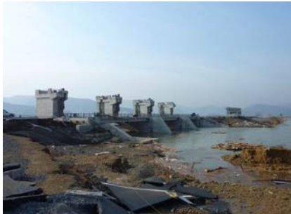
月浜第一水門
