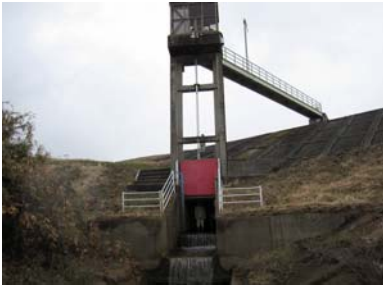
鬼橋排水樋管
