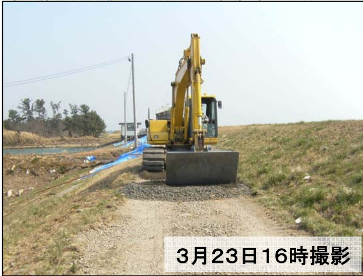
0.4k~1.0k付近の進入路補修状況
