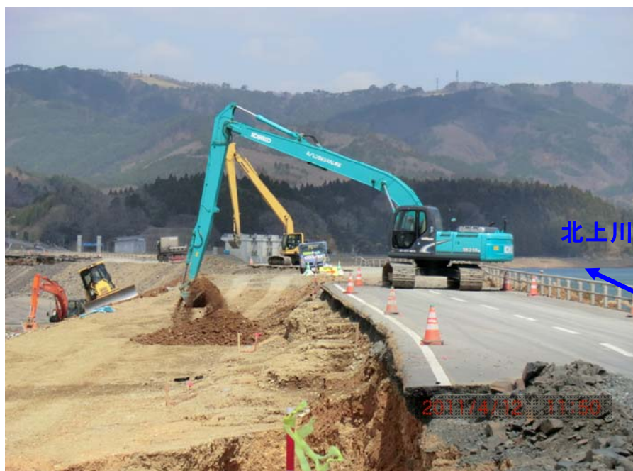
堤防の欠損部の復旧状況
