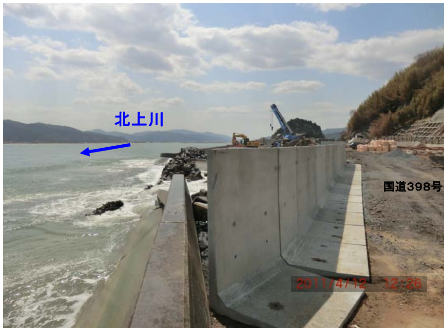
防潮堤防の復旧状況
