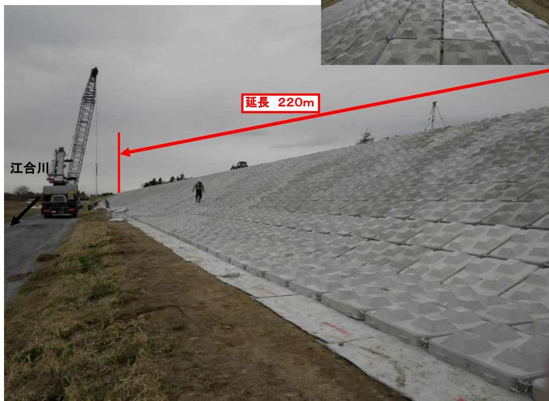
コンクリートブロック張り完了状況 ※ 4月11日撮影
