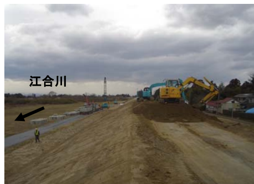
復旧盛土実施状況 ※ 4月8日撮影
