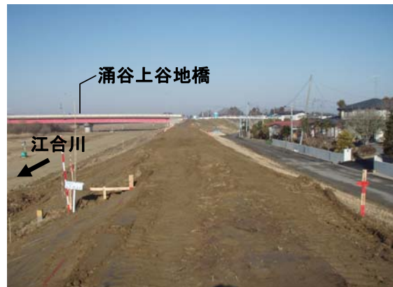
復旧盛土完了状況
