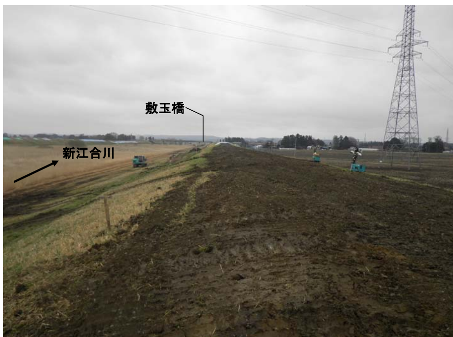
堤防の復旧盛土完了。 ※ 4月9日撮影
