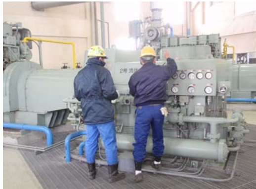
鳴瀬川 鈴根五郎排水機場 大崎市松山次橋
