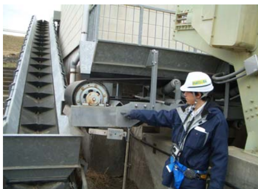
北上川 相野谷排水機場 石巻市相野谷地先
