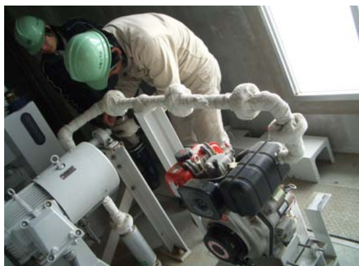
旧北上川 大樋排水樋管 石巻市南境町
