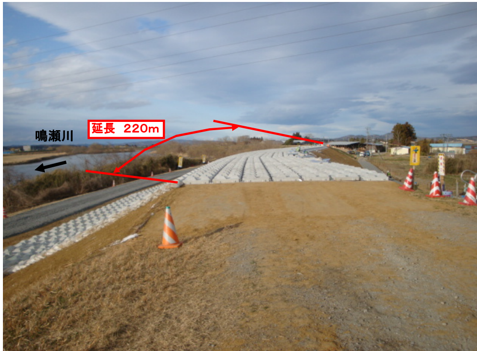
緊急復旧工事完了 ※ 4月8日撮影
