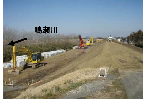
復旧盛土状況 ※ 4月1日撮影
