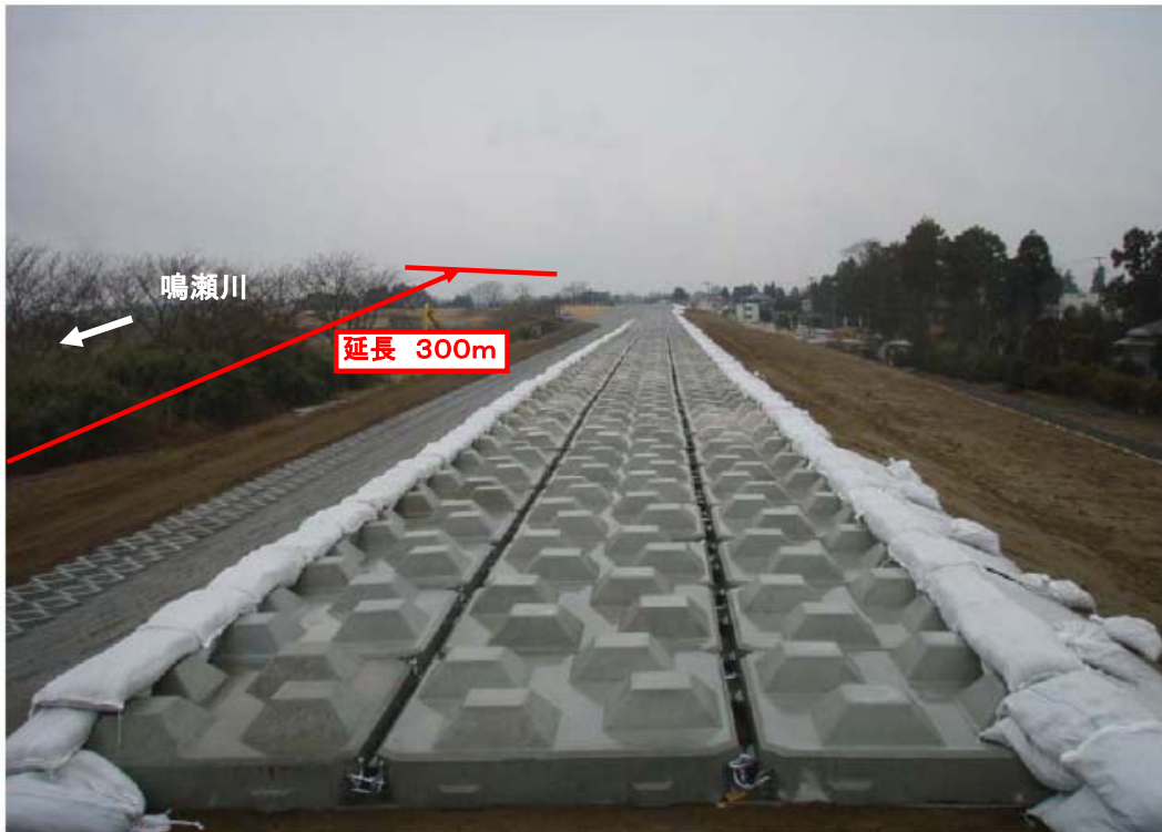
緊急復旧工事完了
