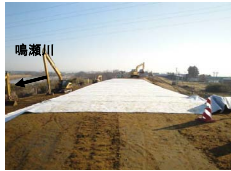
復旧盛土完了、遮水シート張り実施状況 ※ 4月1日撮影
