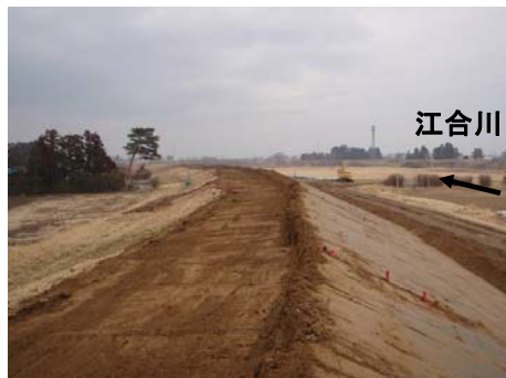
復旧盛土完了状況 ※ 3月21日撮影
