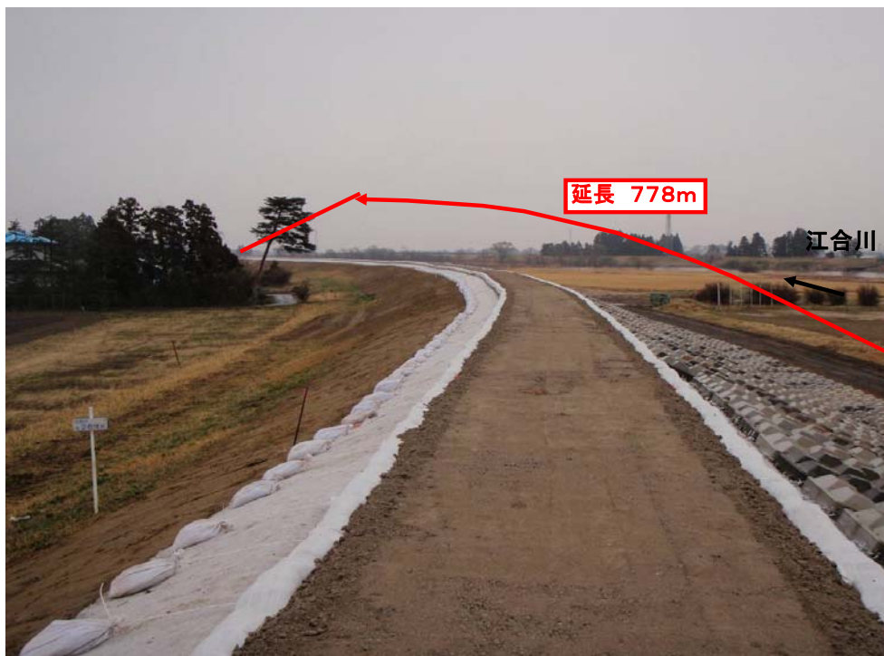
緊急復旧工事完了
