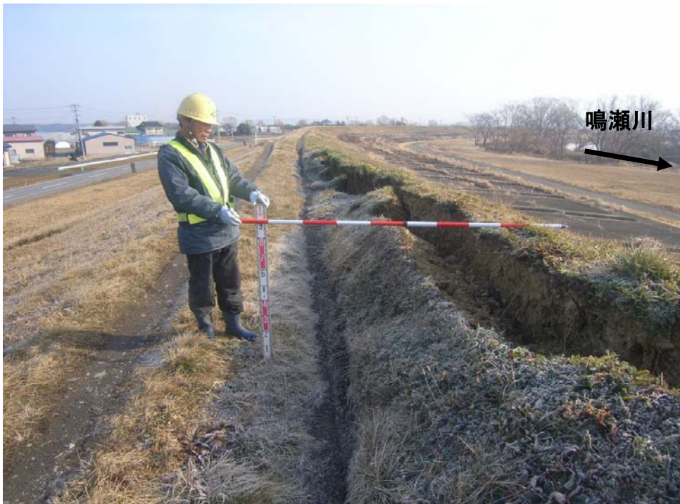
4月7日緊急復旧工事に着手
