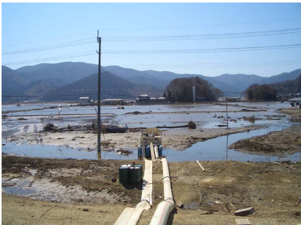
石巻市釜谷地区 浸水解消エリア①の排水状況
