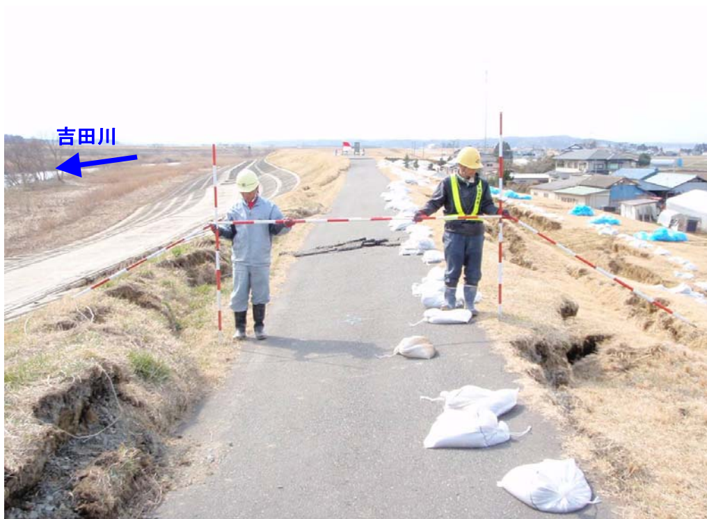
4月6日 緊急復旧工事に着手
