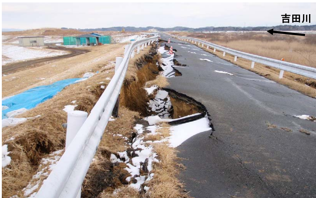
4月6日 緊急復旧工事に着手
