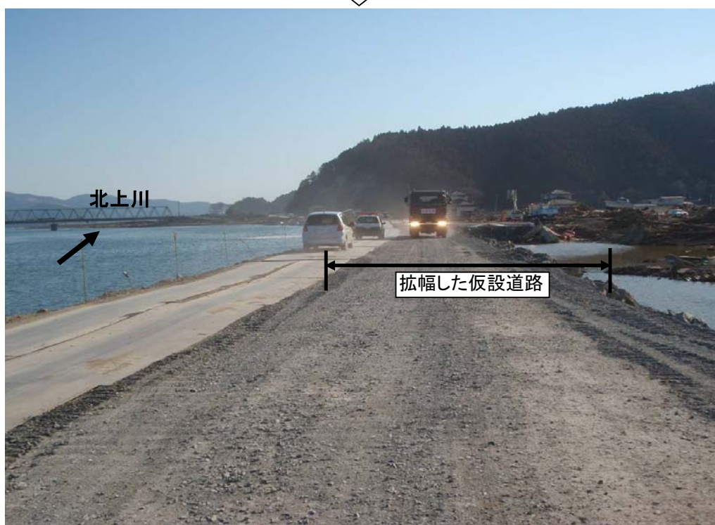
拡幅が完了し、対面通行が可能になった仮設道路(2車線) ※4月6日撮影
