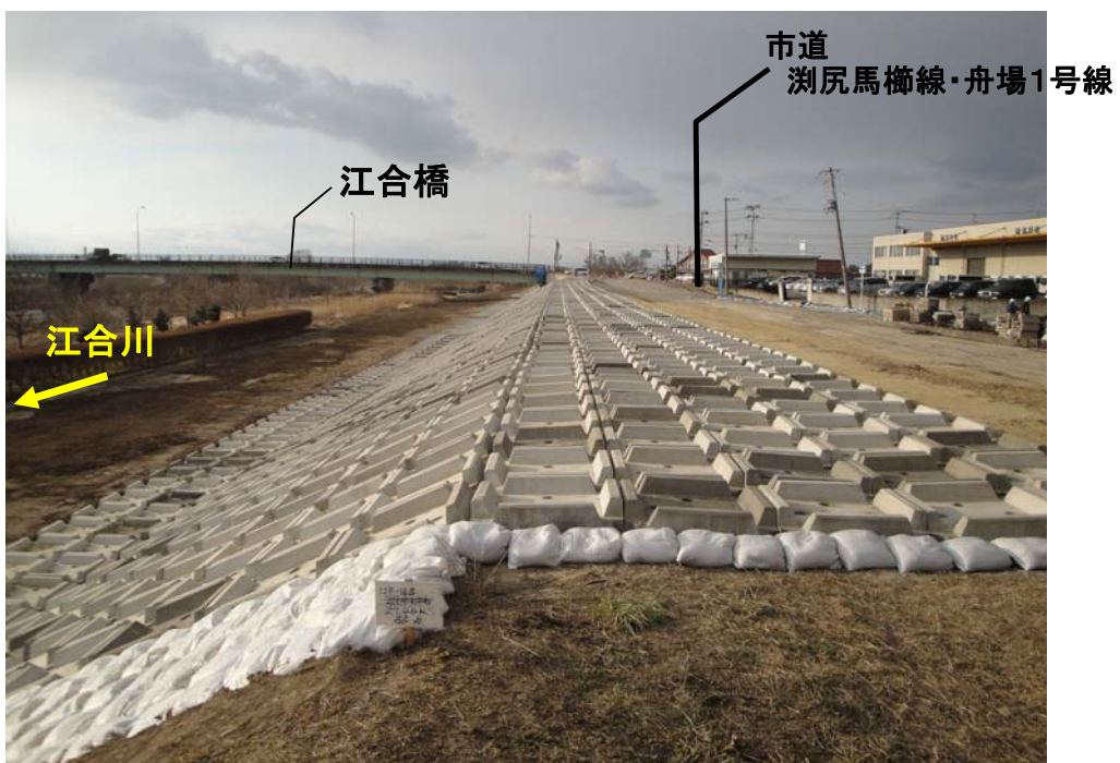
3月31日 コンクリートブロック張り、市道部盛土の完了状況
