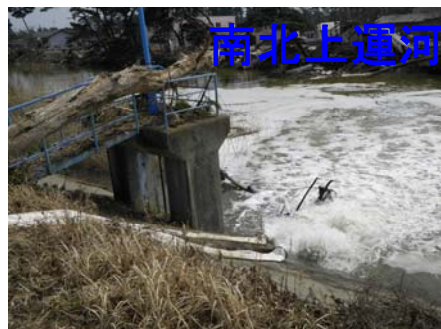
東松島市上浜橋付近 3月30日11時頃 排水ポンプ車による排水状況(30m 3 /m 1台)
