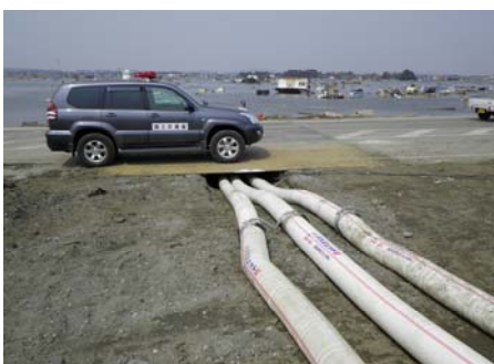
東松島市大曲浜新橋 3月30日11時頃 排水ポンプ車による排水状況(30m 3 /m 1台)
