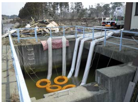
東松島市下街道排水機場 3月30日11時頃 排水ポンプ車による排水状況(30m 3 /m 1台)
