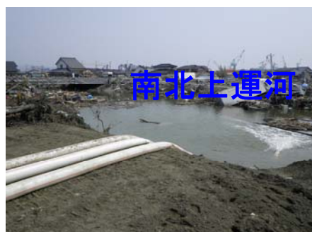
東松島市大曲浜新橋 3月30日11時頃 排水ポンプ車による排水状況(30m 3 /m 1台)
