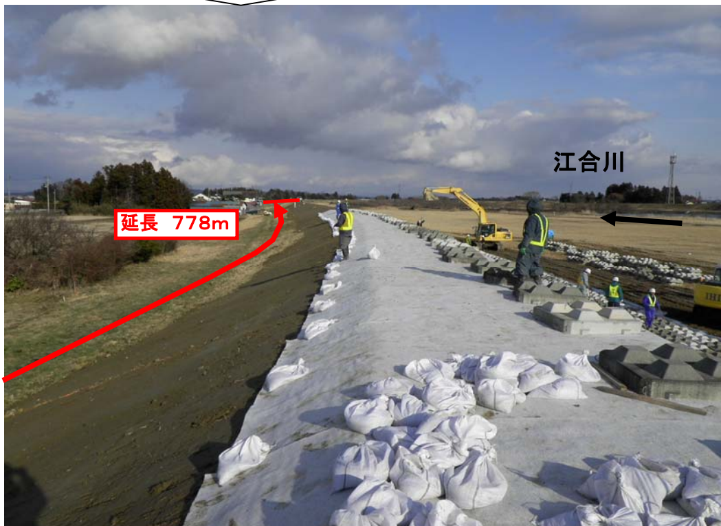
3月26日15時頃 堤防亀裂・沈下の復旧盛土完了しコンクリートブロック 張り実施中
