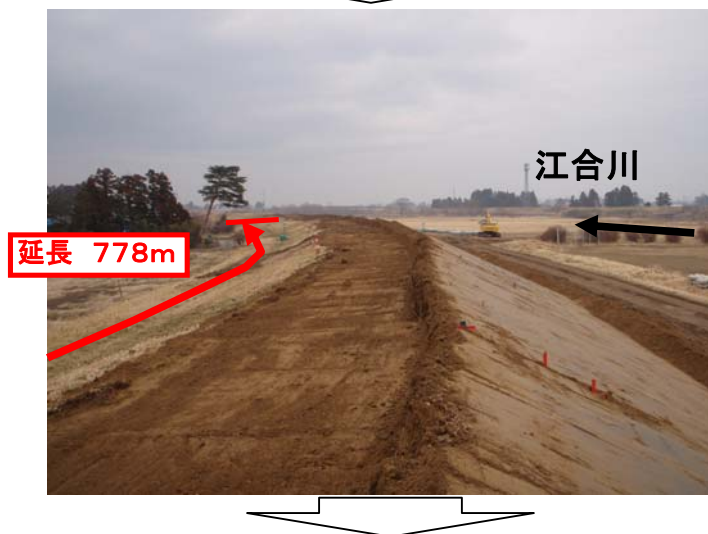
3月21日の工事の状況。 3月17日、緊急復旧工事に着手し、 復旧盛土の実施状況。
