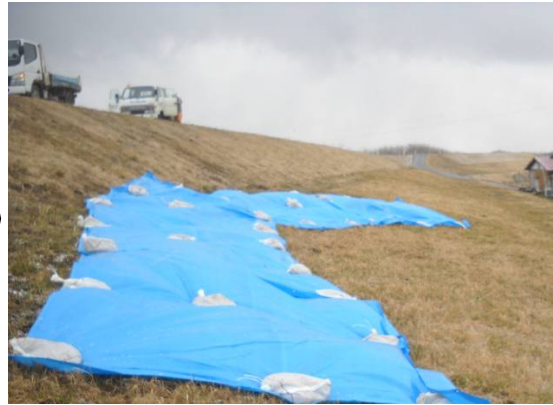
北上川右岸 登米市中田町上沼(45.4k+100m) 応急対策後 3月16日シート張り完了 (堤防の居住側の堤防斜面)
