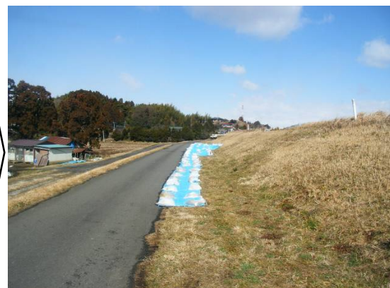
吉田川右岸 松島町竹谷(7.2k) 応急対策後 3月18日シート張り完了 (堤防の居住側の堤防小段)
