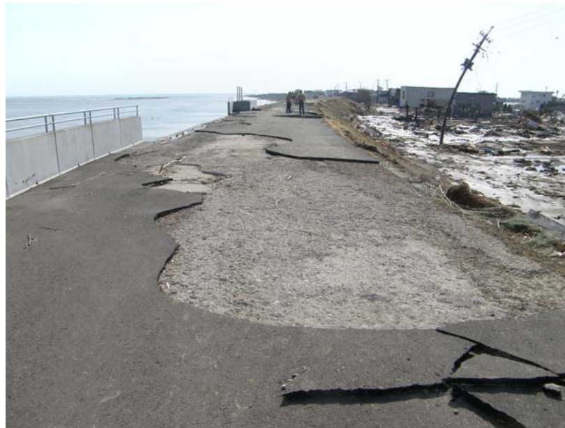
写真⑫ 堤防被害状況 (河口から右岸0.8k付近 亶理町荒浜地先)
