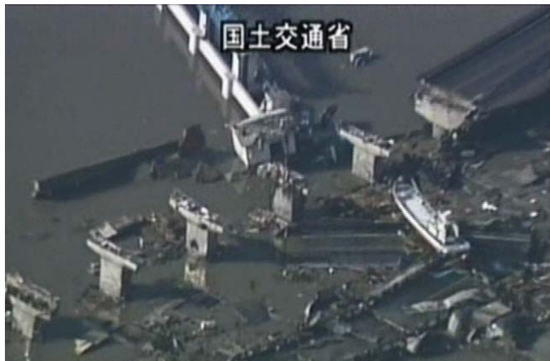
【写真④ 国道45号】(ヘリコプターによる上空画像) 落橋:歌津大橋(南三陸町歌津町字伊里前地内)
