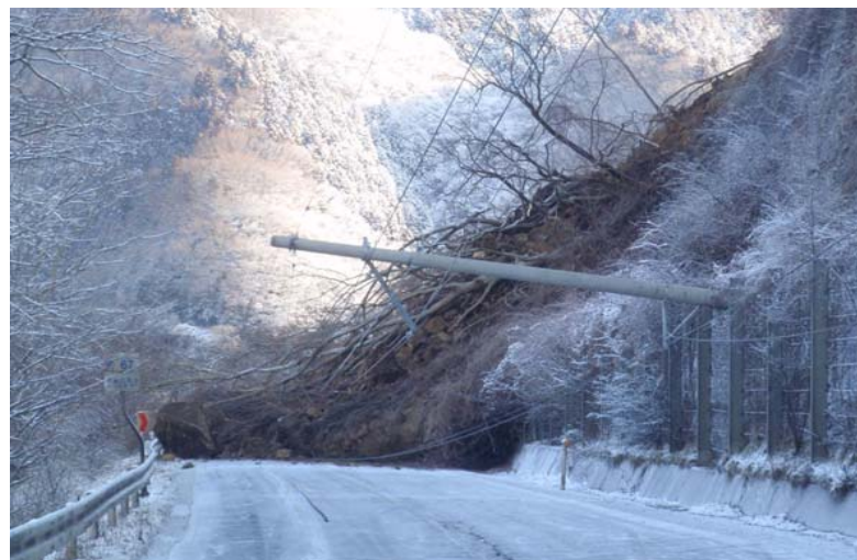
【写真③ 国道45号】 法面崩落(石巻市河北町大字成田地) 石巻方面から気仙沼方面(北方向)を撮影
