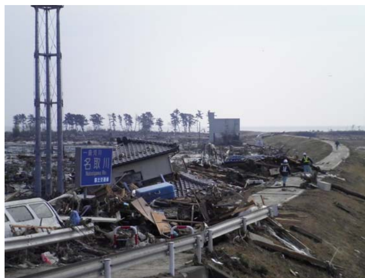
写真⑳ 現地状況 (河口から左岸2.0k付近 仙台市若林区日辺地先)
